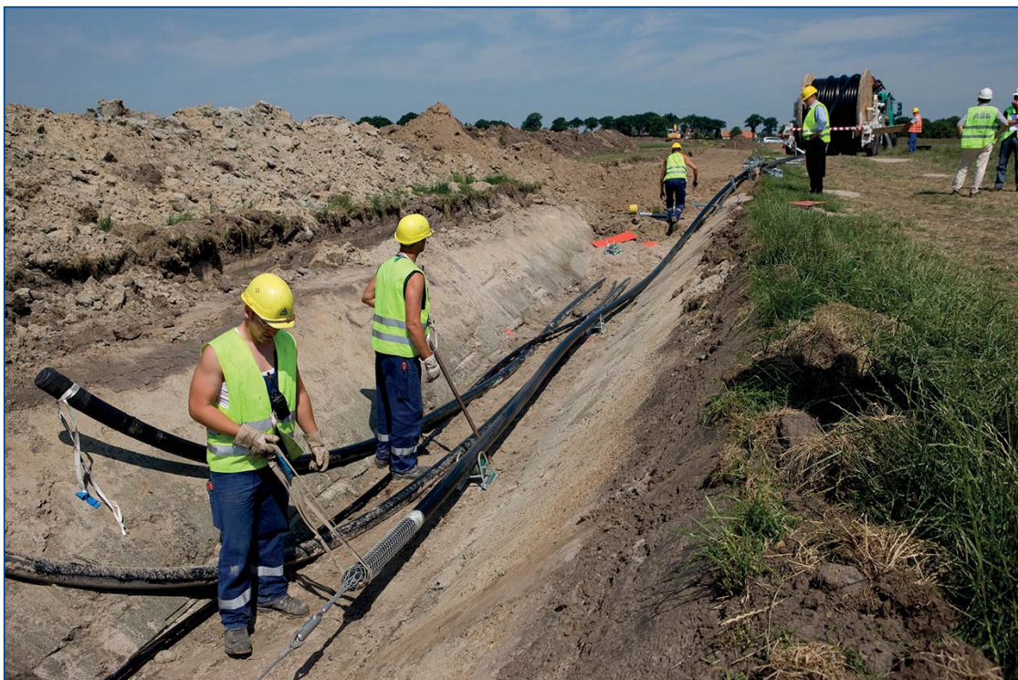
Abb. 3.26: Verlegung von HGÜ-Landkabeln | Foto: ABB AG
