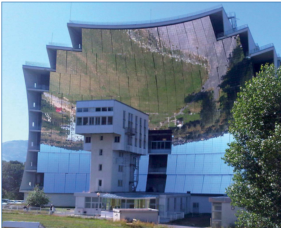
Abb. 3.5: Die solarthermische Versuchsanlage im spanischen Odelló mit ihrem achtstöckigen Parabolspiegel entspricht dem Prinzip eines Solarturmkraftwerks | Foto: Gerhard Hofmann, Agentur Zukunft
