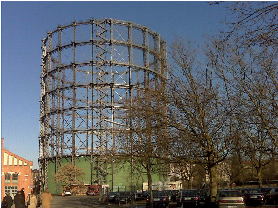
Abb. 3.19: Historisches Gasometer in Berlin – moderne Gasnetze verzichten vollständig auf diese beeindruckenden technischen Bauwerke | Foto: Gerhard Hofmann, Agentur Zukunft
