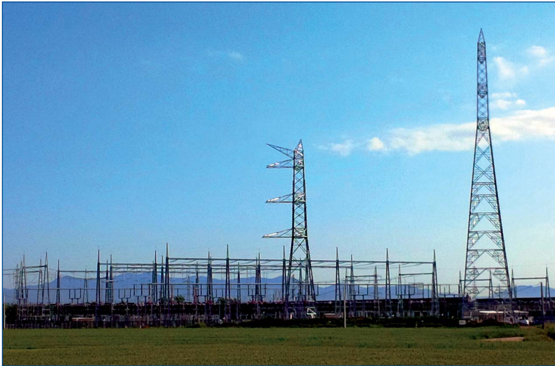
Abb. 3.25: Im Bau befindliche Umspannstation und HGÜ-Leitung in Figueres, Nord-Spanien
